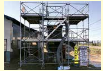
滝野沢地内工事現場の状況
