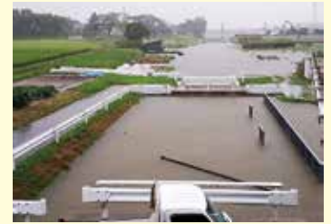
茨野排水機場付近の冠水状況
