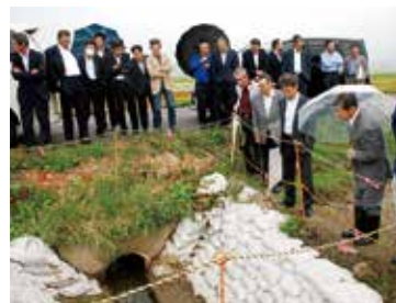
排水路の管路化
