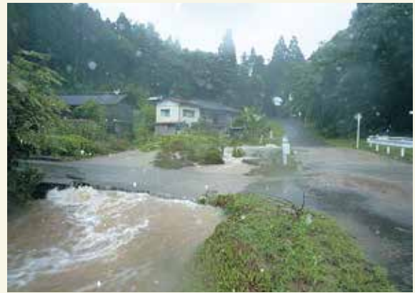
新山地内 浸水被害の状況
