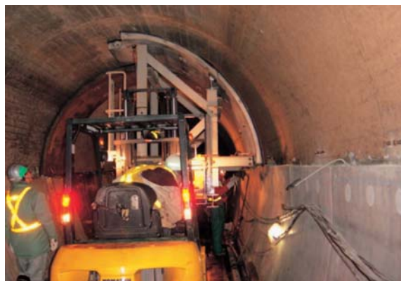
導水幹線トンネル
