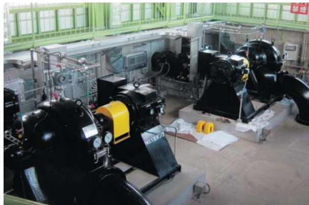
平田揚揚水機場
