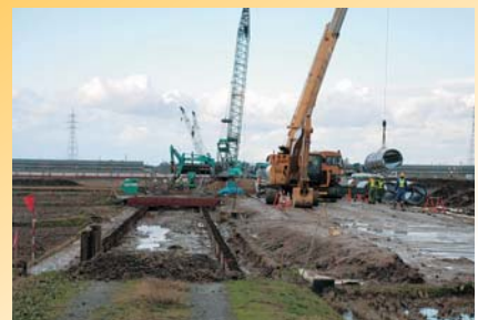
前川第2幹線用水路工事
