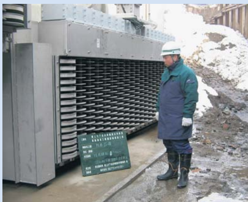
新設された除塵機
