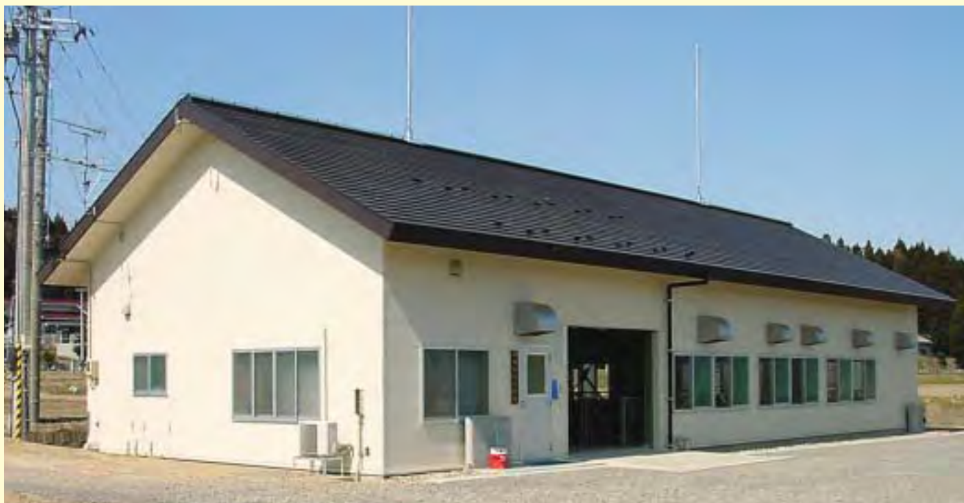
平田揚揚水機場全景
